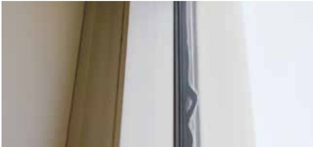
Un joint d'étanchéité défectueux diminue les capacités d'isolation d'une fenêtre.
