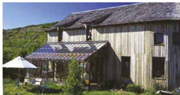
La toiture de cette véranda est constituée de capteurs solaires thermiques.
